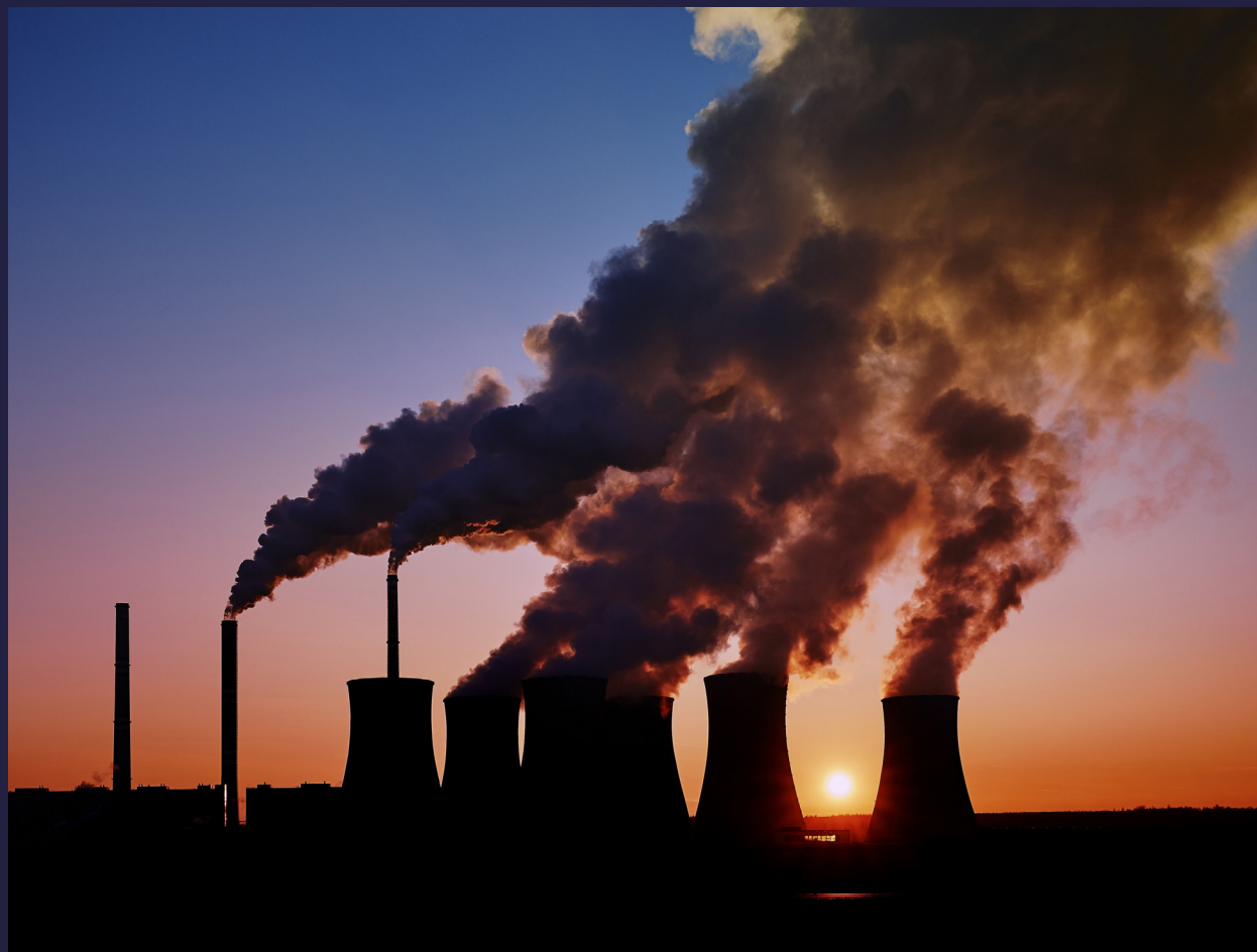
Uhelná elektrárna v Počeradech
